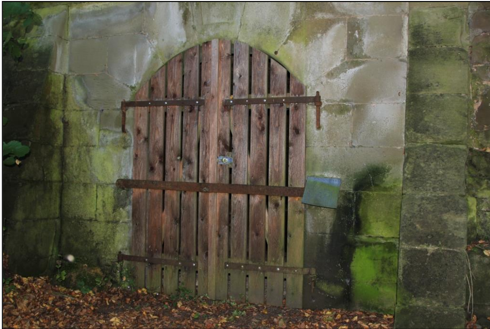
Abb. 5: Fledermausfreundliche Holzgittertür des Gemeindegewölbes in Stübach (TF .04), angebracht vom Arbeitskreis Fledermausschutz im Lkr. Neustadt / Aisch-Bad Windsheim (Foto: M. Hammer)
