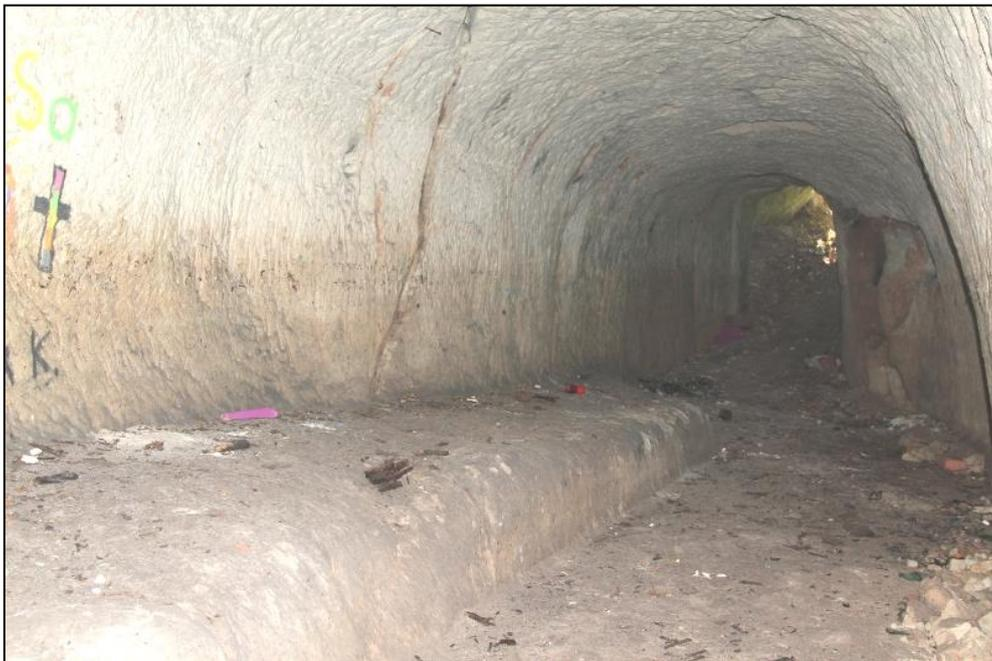
Abb. 46: Innenansicht des „Dachskellers“ in der Nähe des Einganges (hinten rechts). An der Kellerwand sind Wasserstandsmarken zu erahnen, die auf die gelegentliche teilweise Überflutung des Kellers hinweisen. (Foto M. Hammer)
