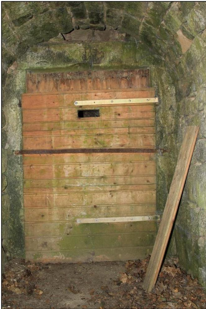
Abb. 25: Kellergruppe in Oberscheinfeld: Holztür des Kellers Nr. 3 mit Einflugöffnung für Fledermäuse (Foto M. Hammer)
