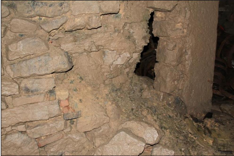
Abb. 26: Kellergruppe in Oberscheinfeld Gravierende Mauerwerksschäden in Keller Nr. 3 (Foto M. Hammer)
