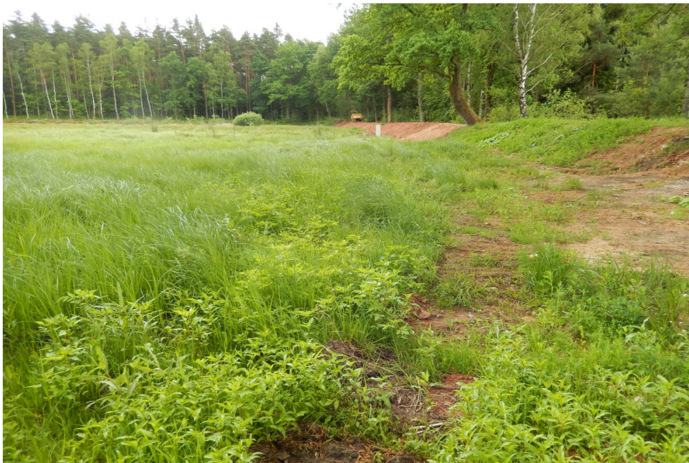
Abbildung 64: Der Große Bühlweiher liegt im Untersuchungsjahr 2015 bei laufenden Bauarbeiten trocken (Foto: M. Ebertshäuser)
