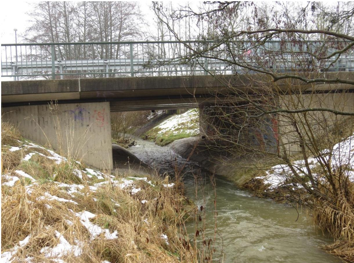
Abb. 30: Brücke mit breitem Betonbankett, das vom Fischotter (*Lutra lutra*) zur Unterquerung trockenen Fußes genutzt wird, am Schmalnohebach bei Sorghof (Kreuzungsbauwerk 3).
