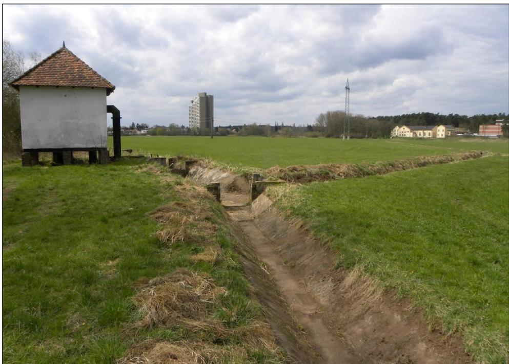
Abbildung 6: Die Wiesenwässerung wird nach wie vor weiter betrieben, jedoch seit langem mit Hilfe von elektrisch betriebenen Pumpen. Diese Pumpenhäuschen finden sich zerstreut am Ufer der Regnitz. Die Wasserzuführung in die Flächen erfolgt in der Regel über betonier- te Rinnen. (Foto: Schott)
