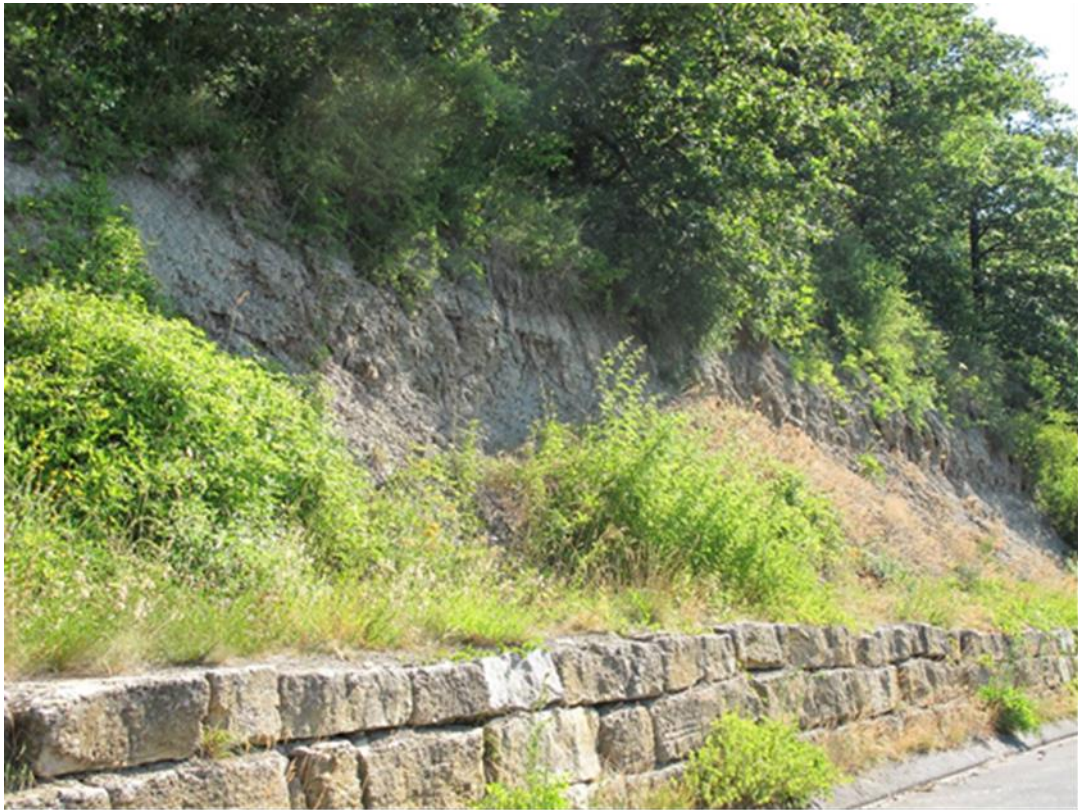
Abbildung 34: Abbruchkante oberhalb des Flurbereinigungsweges am Schwanberg. Darüber liegen, teilweise bereits im Wald, einzelne kleinere Felsbildungen.
