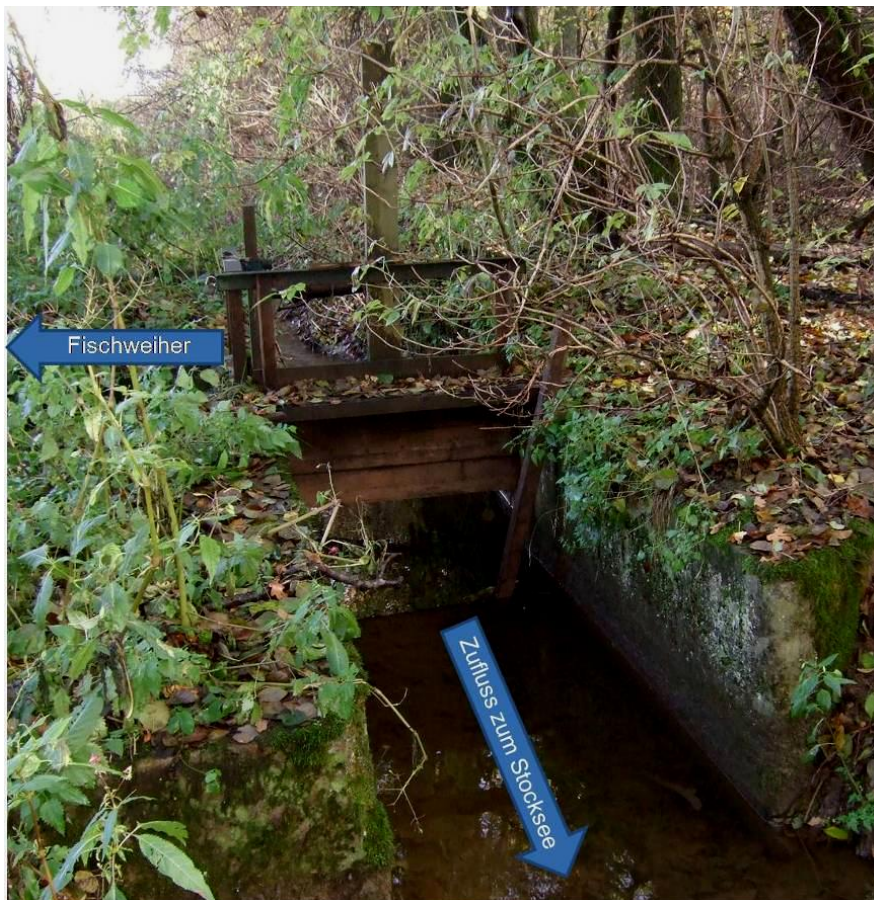
Abb. 14: Ein Wehr zur Regulierung des Wasserregimes des Stocksees (außerhalb des FFH-Gebietes)
