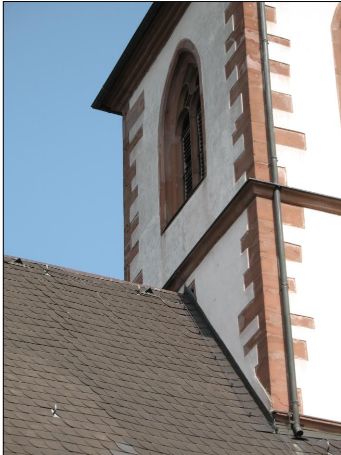
Abb. 8: Katholische Kirche St. Michael in Thüngersheim: Anschluss des Langhausdachstuhles an den Turm. Der Kreis markiert die Fensteröffnung, durch die die Mausohren in den Turm und womöglich auch direkt ins Freie fliegen. Weitere vermutete Ausflugsöffnungen sind die unvergitterten Schallluken (vgl. Text). Foto: M. Hammer
