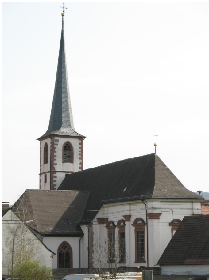
Abb. 7: Die katholische Kirche St. Michael in Thüngersheim (TG .02). Die Ellipse markiert den bevorzugten Hangplatz der Tiere im First des Langhausdachstuhles, vor der Giebelwand, die den Dachstuhl über dem Chor (rechts im Bildvordergrund) abtrennt. Foto: M. Hammer
