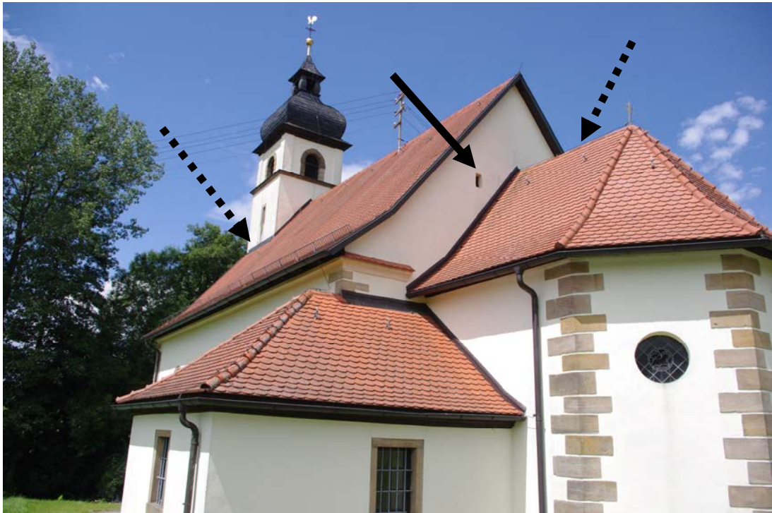
Abb. 7: Kath. Kirche in Ehrl: Der Aus- und Einflug erfolgt über die Öffnungen in der östlichen Giebelwand sowie die Fenster im Turm (gestrichelte Pfeile: Öffnungen im Bild nicht sichtbar). (Foto: A. Niedling).
