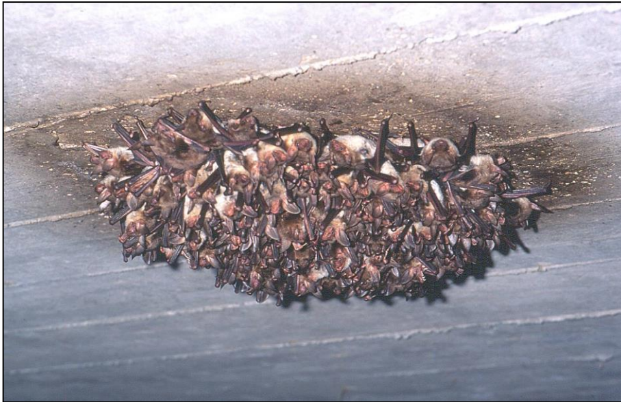
Abb. 18: Mainbrücke Bettingen der BAB A3 (TG .09). Teile der Mausohr-Kolonie an einem typischen Hangplatz: Die Betondecke des Widerlagers ist zugleich die Fahrbahunterseite der Autobahn. Foto: M. Hammer
