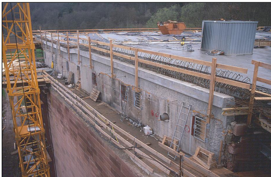
Abb. 19: Mainbrücke Bettingen der BAB A3 (TG .09). Das „Widerlager Frankfurt“ während der Baumaßnahmen (vgl. Text). In dieser Phase des Neubaus waren die alten Fahrbahnüberbauten bereits abgerissen, die neuen aber noch nicht eingeschoben bzw. neu gebaut worden, so dass der Blick auf die Lagervorderseite möglich war. Als Ausflugsöffnungen nutzt die Kolonie die vergitterten Luken vom Widerlagerbalkon (Vordergrund) in das Lagerinnere. Die Gitter wurden nach Abschluss der Baumaßnahmen auf Intervention der Koordinationsstelle wieder entfernt. Foto: M. Hammer
