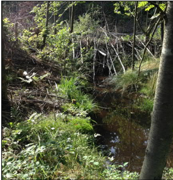
Abb. 50: Biber-Damm am Metzengraben unterhalb der ehemaligen Teiche
