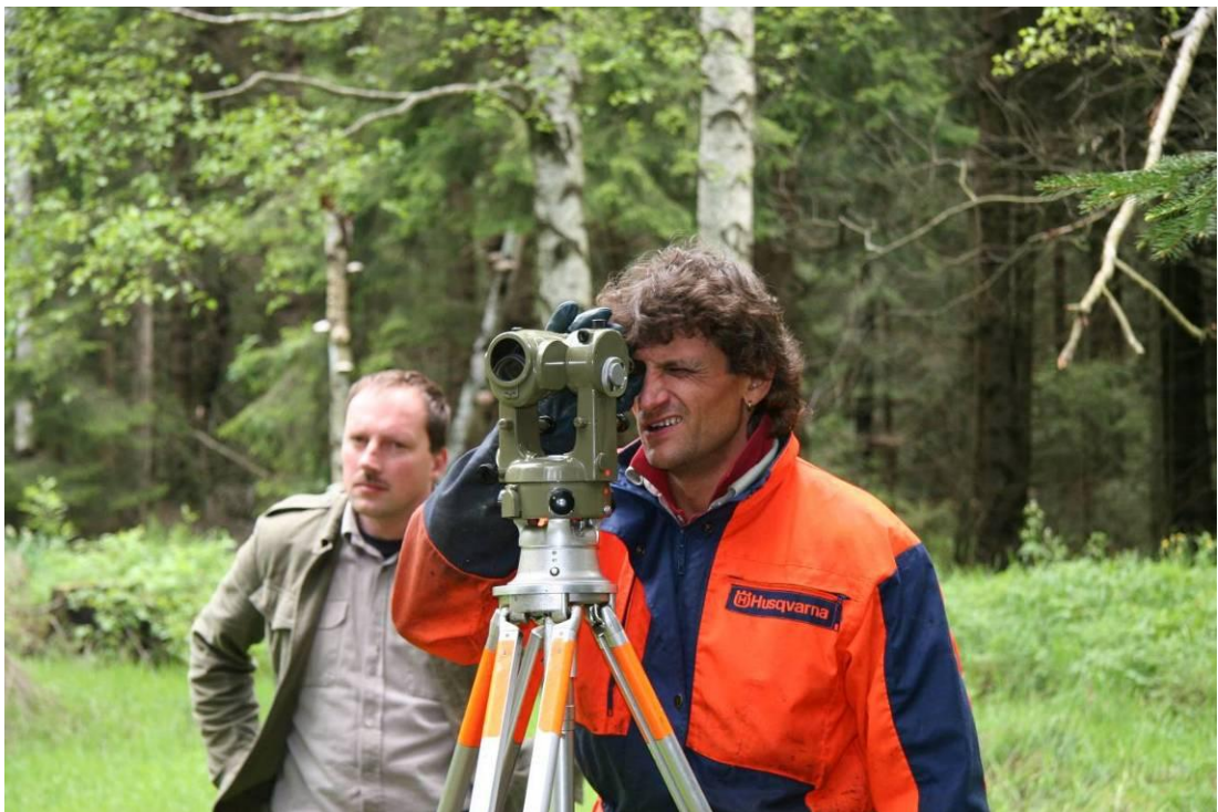
Abbildung 2: Mitarbeiter des AELF Bamberg beim Einmessen der Entwässerungsgräben (Foto: M. Hertel)
