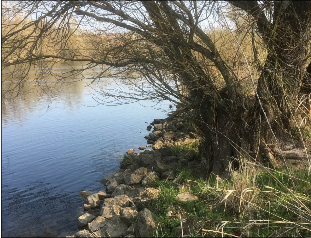
Abb. 23: Deckwerk aus geworfenen Wasserbausteinen als Ufer-Erosionsschutz (Foto: J. ERBEN)
