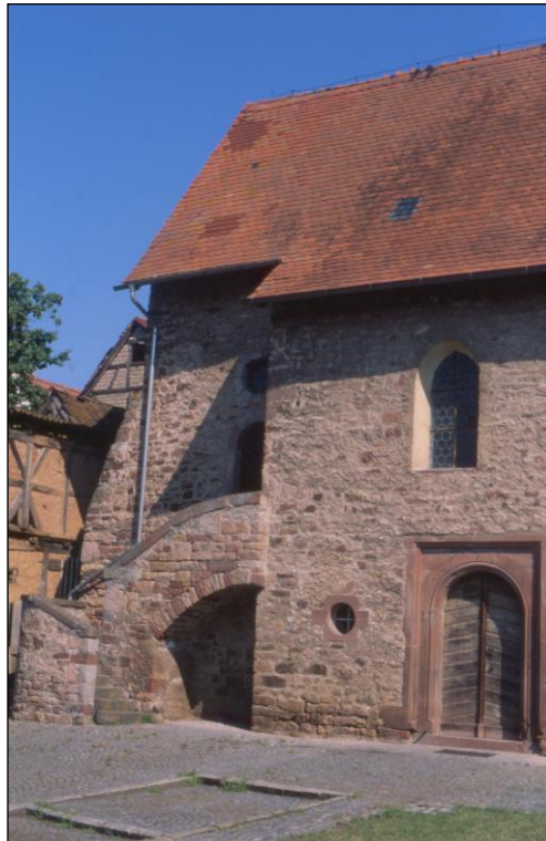
Abb. 3: Westende des Langhauses der Kirche in Diebach (TG 01) mit der Ausflugöffnung unter der Traufe (obere Bildhälfte links). Foto M. Hammer
