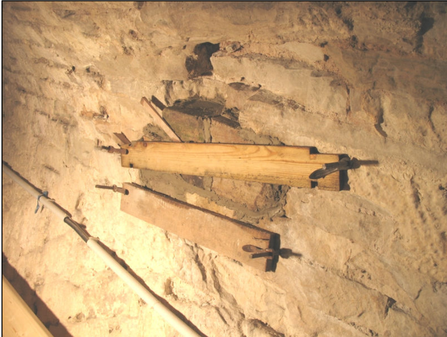
Abb. 20: Bauarbeiten im „Gang unter der Gaststätte“ („Herzchengang“, Bastion 1) der Festung Rosenberg (Tf .01) am 09.02.2007. (Foto: M. Hammer)
