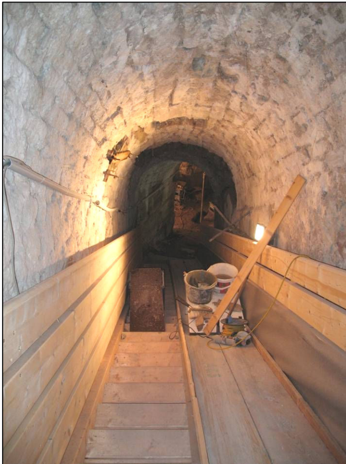
Abb. 19: Bauarbeiten im „Gang unter der Gaststätte“ („Herzchengang“, Bastion 1) der Festung Rosenberg (Tf .01) am 09.02.2007. (Foto: M. Hammer)
