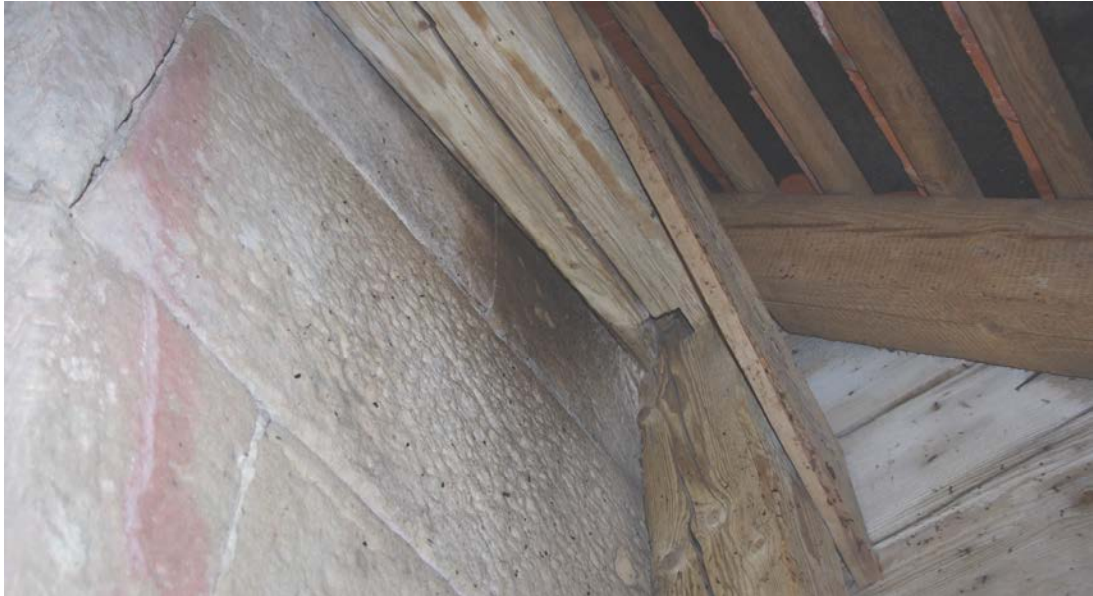
Abb. 8: Evangelische Kirche Mistelgau: südliche Ausflugsöffnung am Übergang des Langhausdachstuhles an die südliche Turmwand. Deutlich zu erkennen ist die Braunfärbung der Mauer durch Körperfette der ein- und aus-schlüpfenden Mausohren (Foto: A. Niedling).
