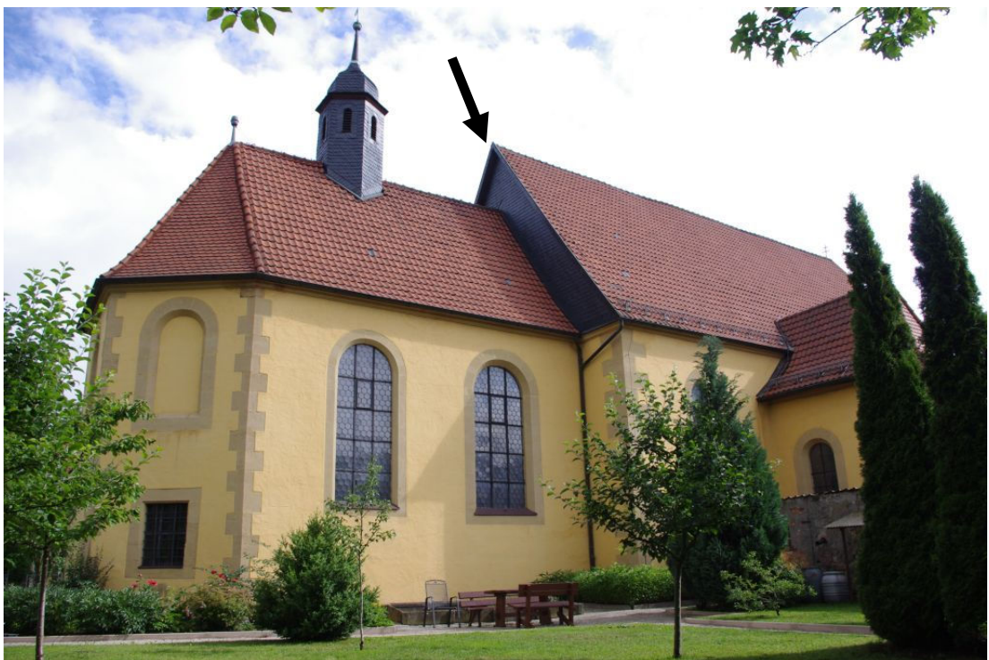
Abb. 8: Oblatenkloster Kronach: Der Ein- und Ausflug erfolgt vermutlich im westlichen Giebelbereich des Langhausdachstuhls (Pfeil) (Foto: A. Niedling).
