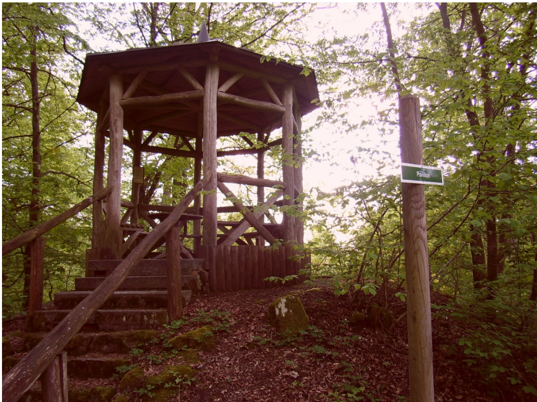
Abbildung 6: Ruhepavillon an einem Wanderweg Foto: G. Schmidt)
