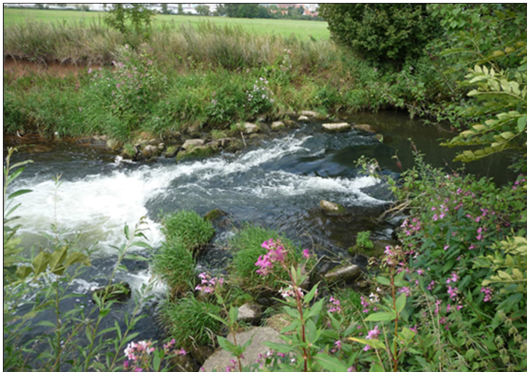
Abb. 20: Sohlrampe zur Sohlsicherung am Beginn der Befischungsstrecke 5 im Naturschutzgebiet Saalewiesen zwischen Bad Neustadt a. d. Saale und Salz, die insbesondere für Fischarten wie die Mühlkoppe nur eingeschränkt passierbar ist. (Foto: M. KOLAHS 2012)
