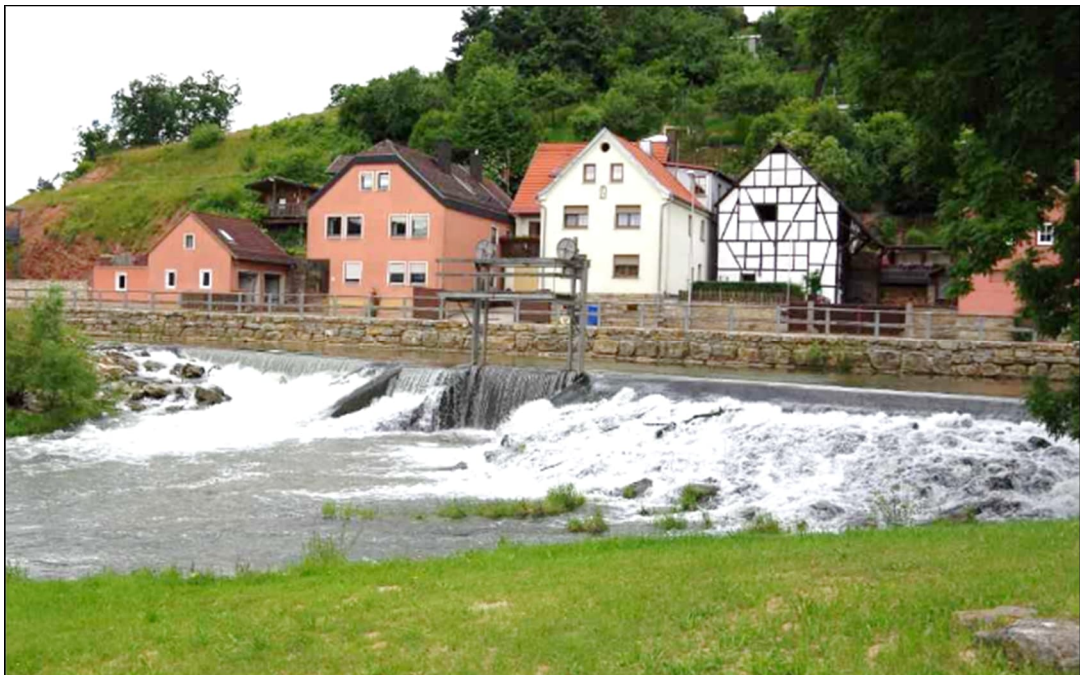
Abb. 21: Nicht durchgängiger Fischaufstieg an der Wehranlage der Mauermühle in Unterebersbach unterhalb Befischungsstrecke 3 (Foto: Dr. W. SILKENAT 2018)
