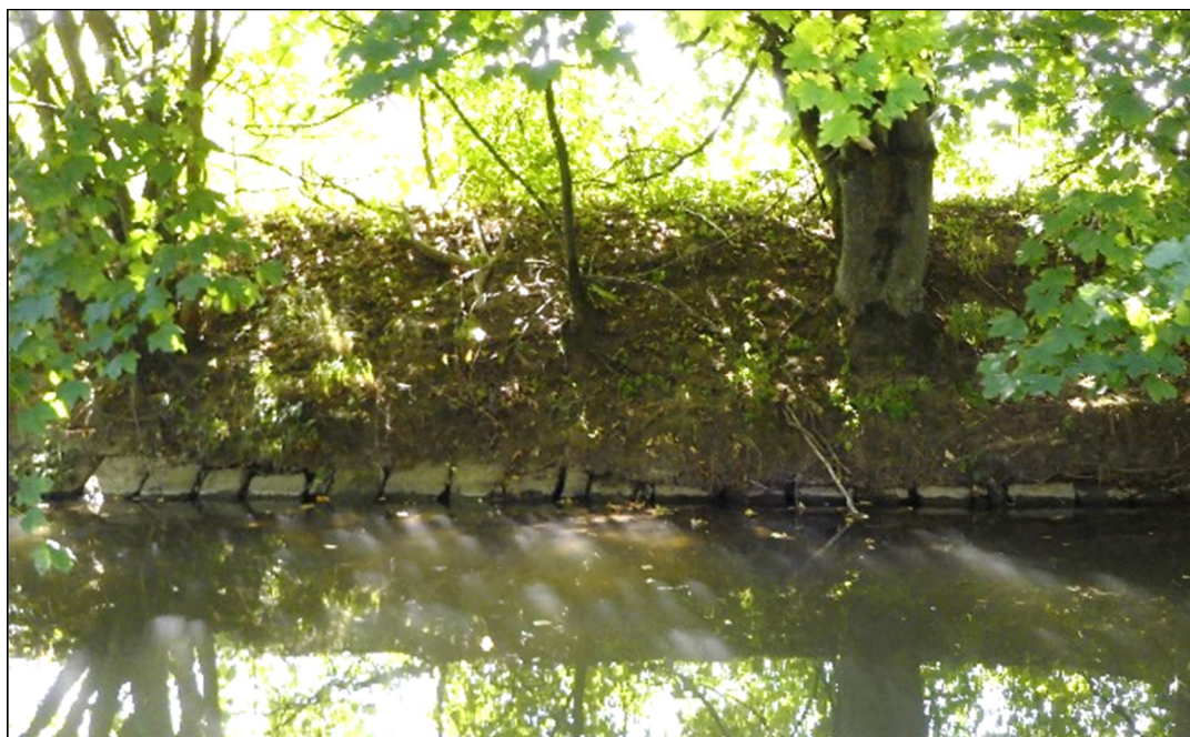
Abb. 24: Begradigter, mit Wasserbausteinen befestigter Abschnitt der Fränkischen Saale innerhalb der Befischungstrecke 3 (Fränkische Saale bei Oberebersbach) (Foto: M. KOLAHSA)
