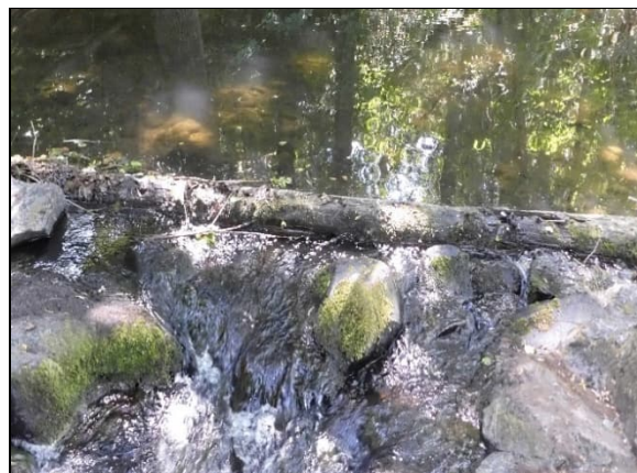
Abb. 23: Für Koppe und Bachneunauge nur bedingt durchgängig gestaltete Sohlrampe (Ende von Befischungsstrecke 2; Foto: MICHAEL KOLAHS, Fischereifachberatung 2019)
