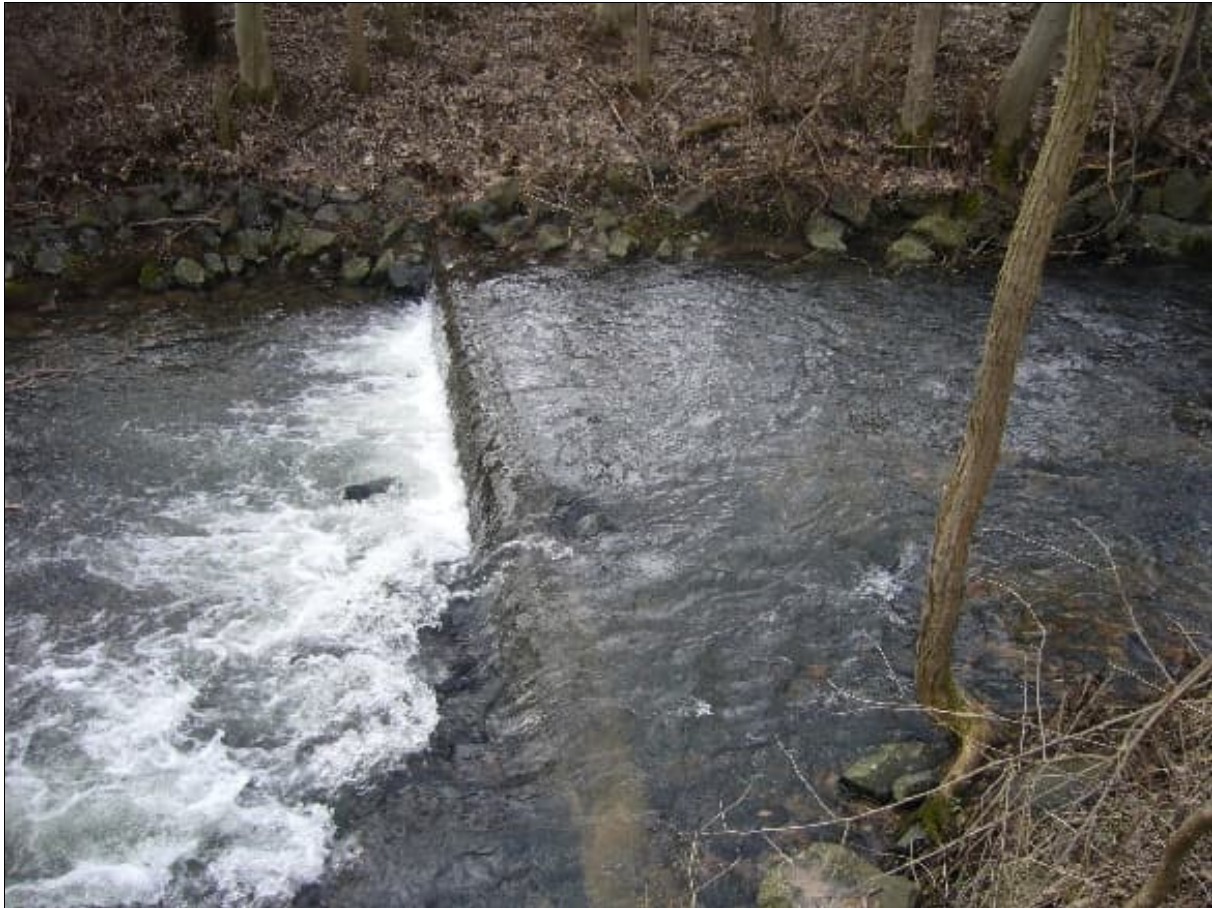
Abb. 26: Sohlschwelle in der Brend mit losgelöstem Wasserstrahl in Höhe des Sportplatzes der Stadt Bischofsheim, die für bodenorientierte Fischarten wie die Mühlkoppe nicht passierbar ist (Foto: MICHAEL KOLAHSA, Fischereifachberatung 2016)
