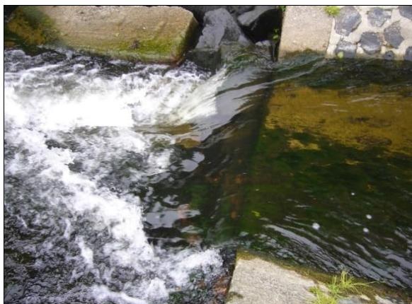
Abb. 22: Der untere Abschnitt des Pegels Schweinhof (Befischungsstrecke 5) ist für die Mühlkoppe nicht, für das Bachneunauge nur bedingt durchwanderbar (Foto: MICHAEL KOLAHS, Fischereifachberatung 2013)
