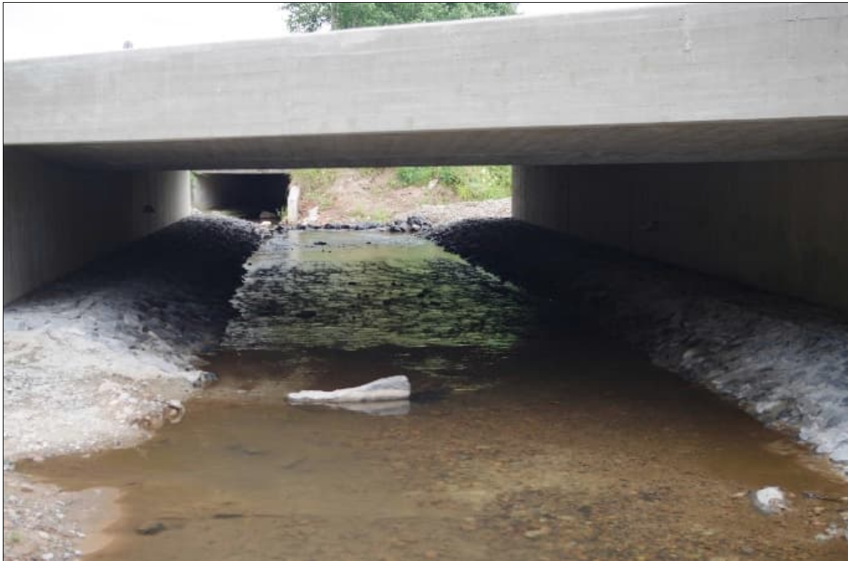
Abb. 27: Begradigter, durch betonierte Steinschüttung festgelegter Abschnitt des Weisbachs im Bereich der B 279, Ortsumgehung Wegfurt (Foto: MICHAEL KOLAHSA, Fischereifachberatung 2018)
