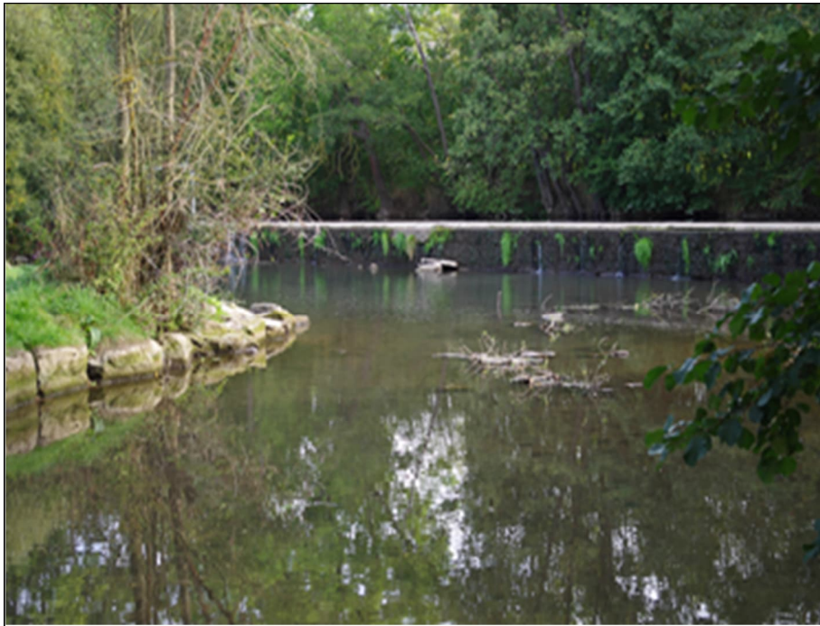
Abb. 44: Nicht durchgängiges Querbauwerk im Bereich von Heustreu mit Blick auf die Ausleitungsstrecke und deren geringfügige Wasserführung in Befischungsstrecke 1 (Foto: M. KOLAHSA)
