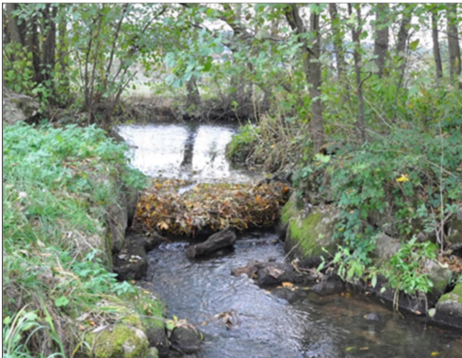
Abb. 45: Vom Biber zugebaute Fischwanderhilfe an der Streu bei Mittelstreu oberhalb Befischungsstrecke 2 (Foto: U. FÖRSTER)
