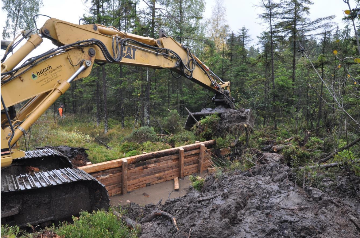
Abbildung 57: Einbau von Spundwänden in den Entwässerungsgraben, Oktober 2011 (Foto: GUNDELACH)
