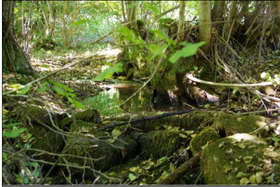
Abb. 40: Für Bachneunaugen und Koppen nicht durchwanderbares Hindernis an Befischungsstrecke 5 (Querbauwerk) (Foto: MICHAEL KOLAHSA, Fischereifachberatung, 2018)
