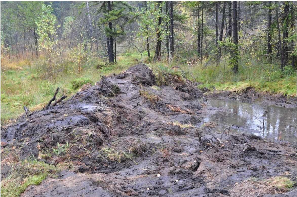
Abbildung 58: Frisch eingebaute und abgedeckte Spundwand, Oktober 2011 (Foto: GUNDELACH)
