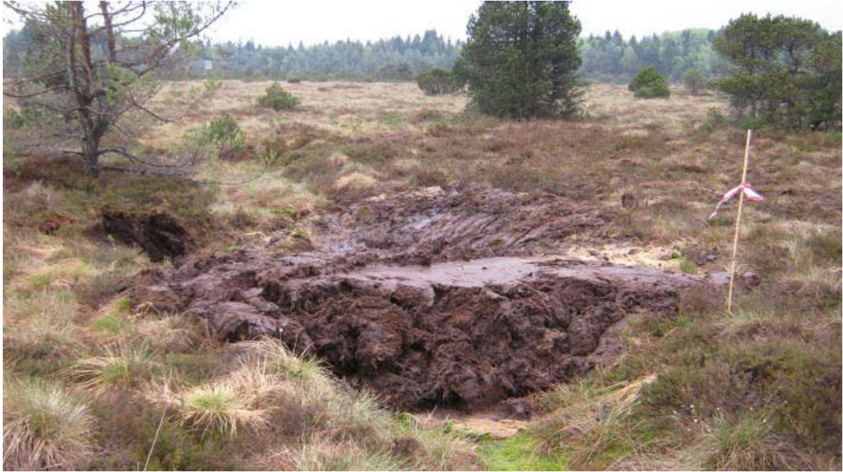
Fertiger, mittelgroßer Torfdamm in einer Grabenmulde- der Torf wurde oberhalb des Dammes aus den Grabenschultern entnommen.
