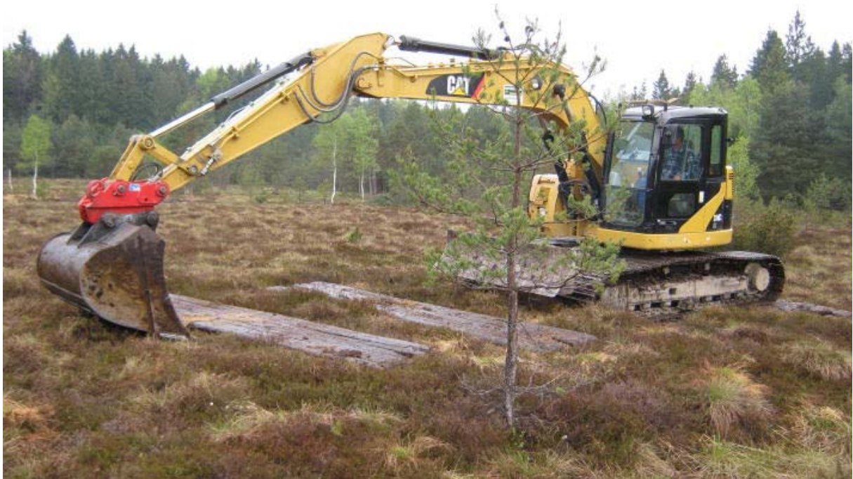
Um ein Versinken des ca. 14 t schweren Baggers im weichen und tiefgründigen Moorboden zu verhindern, wurden zur Fortbewegung umschichtig vier sog. Baggermatrazen aus Hartholz ausgelegt.
