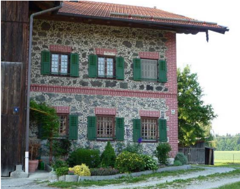
Mauerwerk aus Achthaler Schlacke und Ziegel (Foto: Isabel Augenstein)
