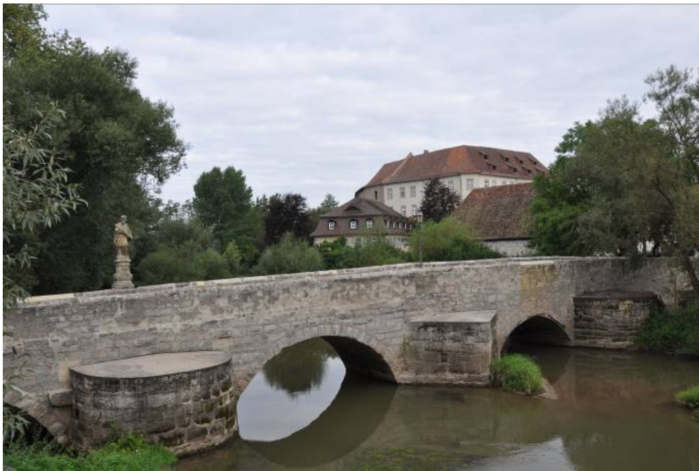
Alte Brücke über die Aisch in Höchstadt (Foto: W. Richter-Tietel)
