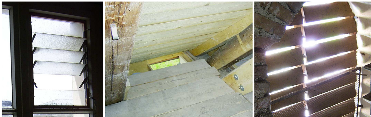
Abb. 2: Links: Lamellen in einem Glasfenster. Mitte: Sich nach unten hin öffnender Einflug im Dachüberstand. Rechts: Schalläden aus Holz mit einer Vergitterung im unteren Bereich.
