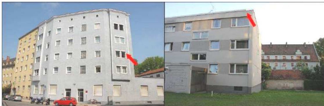
Abb. 18: Beispiele für neu entdeckte Wochenstubenquartiere der Weißrandfledermaus: Brückenstraße, Rollokasten (links) und Berliner Allee, Blechverkleidung (rechts).
