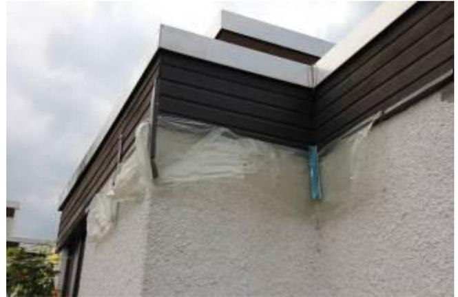
Abb. 21: Abendseglerquartiere in Wasserburg, Innhöhe. Öffnung unerlaubt verschlossener Quartiere und Anbringung von Fledermausabweisern an Stellen, die verschlossen werden dürfen (rechtes Bild).
