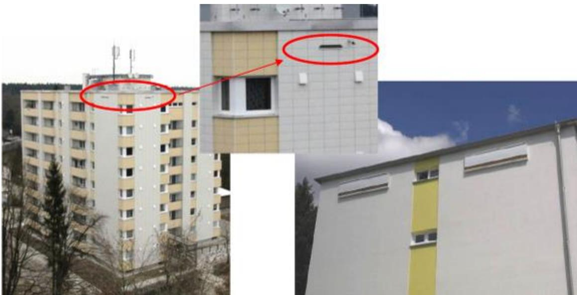
Abb. 9: Neue Abendseglerquartiere in und auf wärmedämmten Fassaden eines umfangreichen Quartiersverbundsystems in Waldkraiburg (Lkr. MÜ).
