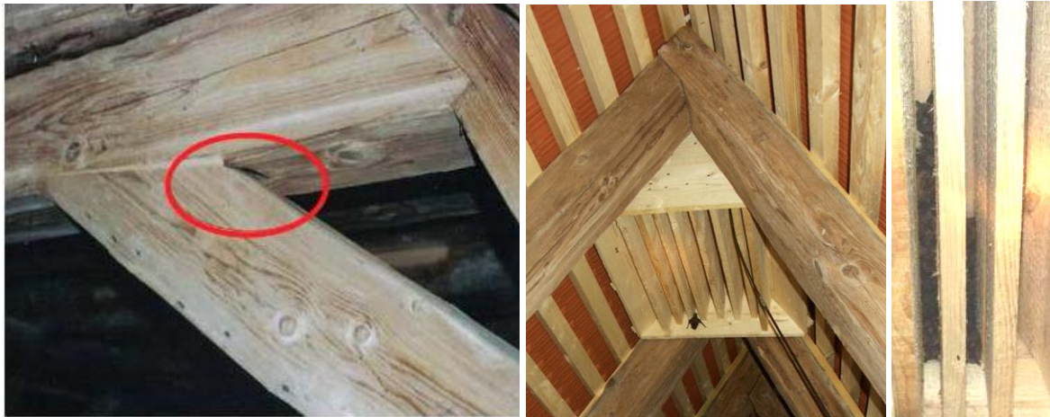
Abb. 7: Quartiere der Großen Bartfledermaus in St. Othmar. Versteck in Balkenverbindung (links), neues Spaltenquartier (Mitte) und Ausschnitt mit Kolonie im neuen Quartier (rechts).
