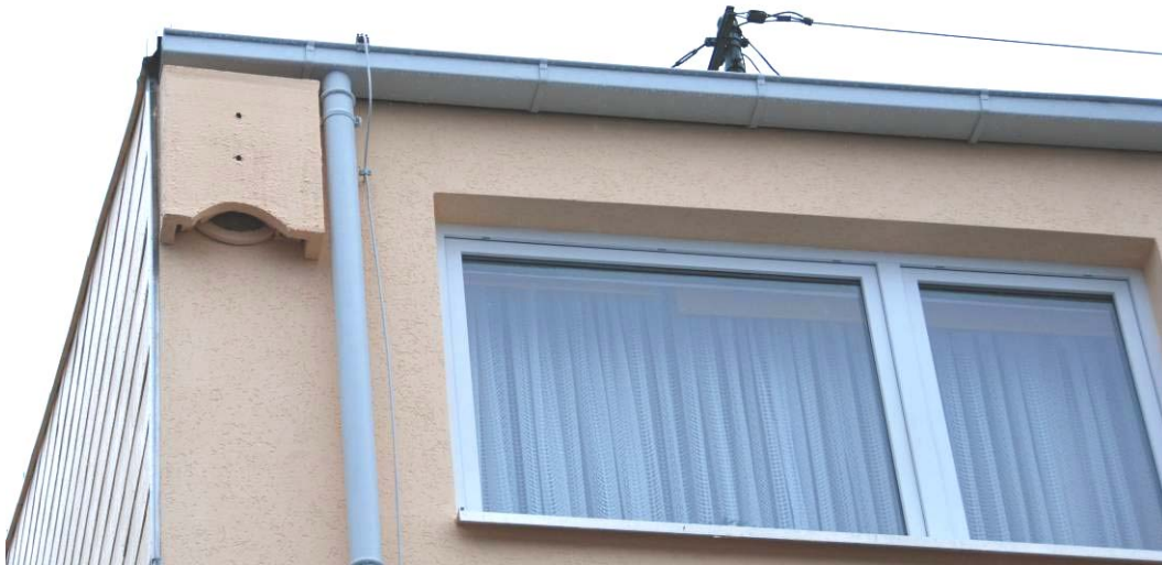
Abb. 8: Ersatzquartier für ein Spaltenversteck unter der Dachrinne. Die Abendsegler haben das Quartier angenommen
