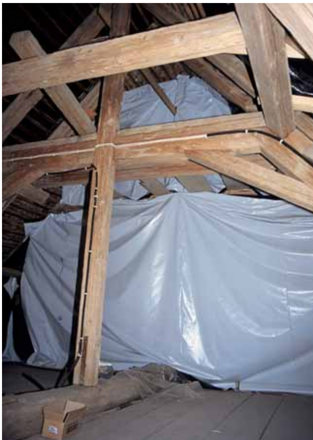
Abb. 6: Dank des regelmäßigen Monitorings der Kolonien kommen beim Großen Mausohr kaum noch Störungen oder Vertreibungen der Wochenstuben durch Renovierungsarbeiten vor. In Ausnahmefällen kann der Teil des Dachbodens mit der Kolonie mit Folie abgetrennt und nicht verschiebbare Renovierungsarbeiten im anderen Teil durchgeführt werden, wie hier in der Kirche von Klähham (Landkreis Landshut) (Foto: Zahn).
