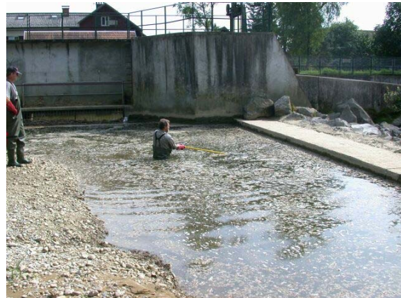
Abb. 38 Sannwaldwehr mit Fischpass und Rückstau im Oberwasser
