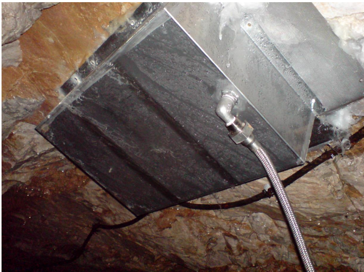
Abbildung 2: Ausführung der luftdichten Fassung des Quellwassers.
