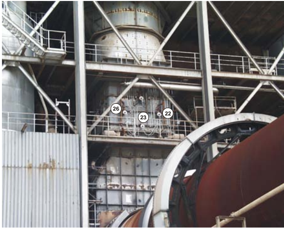
Abb. 5: Injektoren auf der 17 m-Bühne
