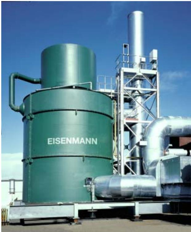
Abb. 7: Regenerative Nachverbrennung RNV, hier in der Kunststofflackierung, arbeitet Energie sparend und kommt dank sehr guter interner Wärmenutzung in der Regel ohne externe Wärmerückgewinnung aus. (Foto EISENMANN)
