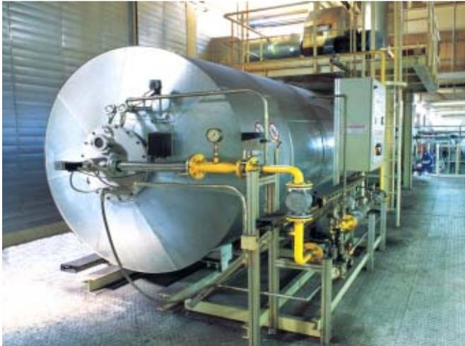
Abb. 3: Thermische Nachverbrennung TNV mit Wärmerückgewinnung – bei der Eliminierung von Geruchsbelästigungen aus der KTL vielfach bewährt. (Foto EISENMANN)
