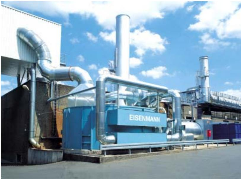
Abb. 11: Das Adsorptionsrad ADR ist insbesondere bei der Minimierung und Aufkonzentrierung großer, nur schwach mit Schadstoffen belasteter Abluftströme bewährt. (Foto EISENMANN)
