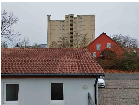
Stationsumgebung Blickrichtung Süd (Aufnahme: November 2021)
