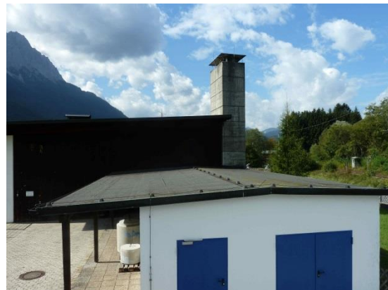
Stationsumgebung Blickrichtung West (Aufnahme: September 2019)
