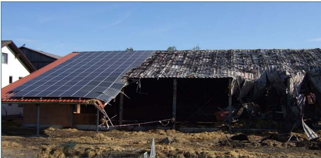
Abb. 1: Typischer Brandschaden einer Photovoltaikanlage 1
