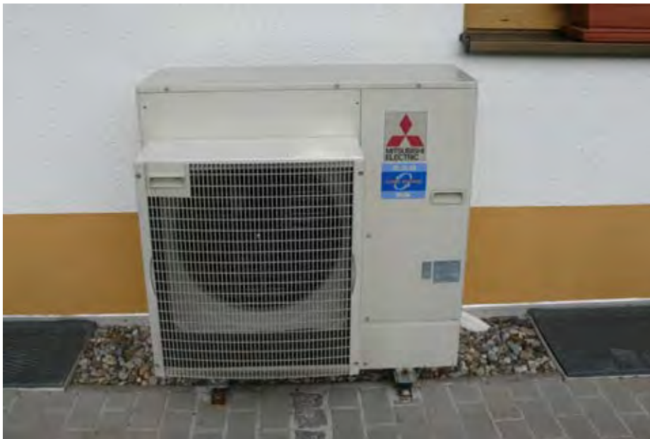
Abb. 32: Wärmepumpe (Schalleistungspegel laut Datenblatt 62 dB(A))
