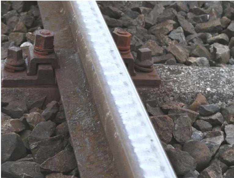
**Schienen-Riffel auf einem Bahngleis nach längerem Betrieb**
