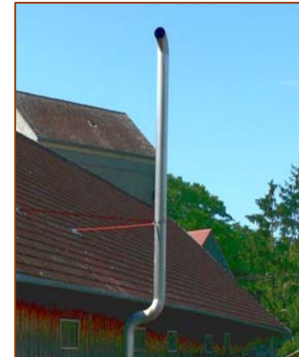
Kamin mit Schalldämpfer, L_{WA} : 70 - 75 \text{ dB(A)}
