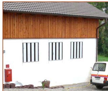
Lüftungsöffnungen, L_{WA} : 75 - 85 \text{ dB(A)} pro Öffnung
