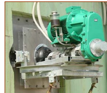
Rührwerk, L_{WA} : 65 - 85 \text{ dB(A)}
