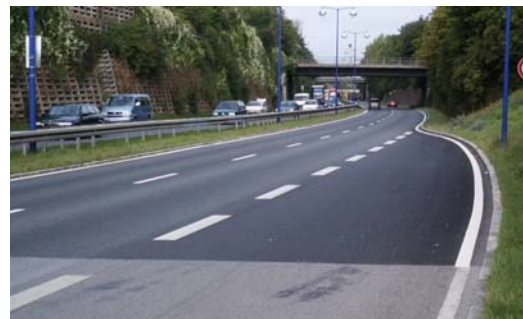
Abb. 5: Aufbau einer zweischichtigen offenporigen Asphaltdeckschicht und B 17 in Augsburg mit Übergang zum offenporigen Belag; Foto LfU
