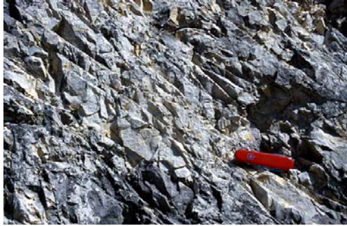
Intensive Feinklüftung in den zerrütteten Kalken.
