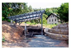
Im Zuge der Arbeiten wurde die ehemals fast senkrechte Aufschlusswand abgeflacht und das Kohleflöz flächenhaft aufgebaggert. Ein Dach dient nun zur Ableitung von Regenwasser und schützt den Aufschluss. Eine angrenzende Böschung wurde tribünenartig abgestützt und bietet einen guten Blick auf das Kohleflöz.
