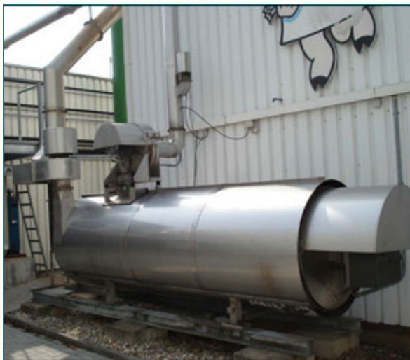
Abb. 11: Thermische Nachverbrennung von Räucher- rauch
