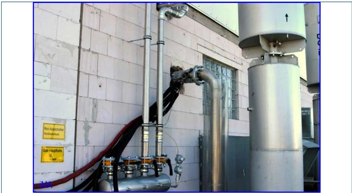
Abb. 6: Probenahmeleitungen an der Abgasführung eines der Zündstrahlmotoren der Biogasanlage Nr. 2
