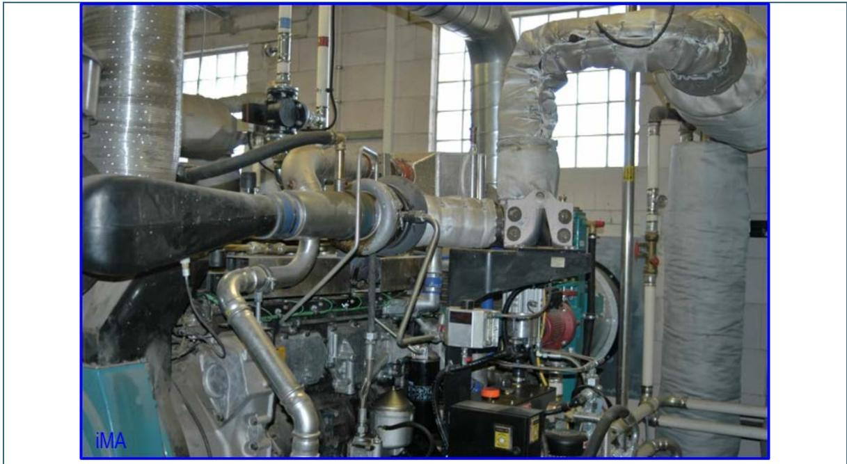
Abb. 5: Zündstrahlmotor der Biogasanlage Nr. 2.
