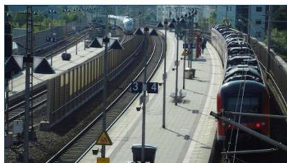
Abb. 5: Eine Mittelwand trennt die Schnellzuggleise von den übrigen Gleisen.
