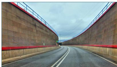
Abb. 6: Trogwände mit schallschluckenden Materialien verbessern den Lärmschutz.
