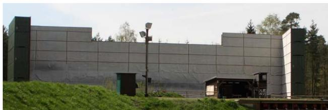
**Abb. 25: Skeetanlage (Textilvliesverkleidung, darunter Holz)**
