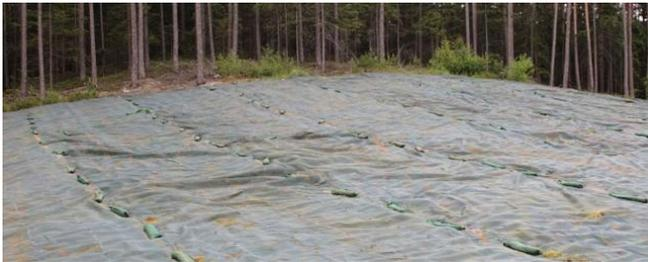
**Abb. 11: Detailansicht, Netze mit Sandsäcken beschwert**
