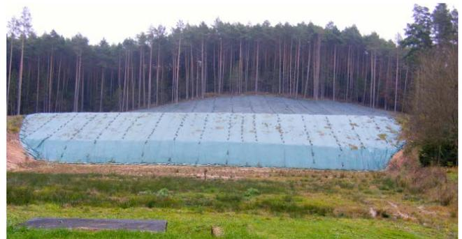
Abb. 8: Trapanlage, flächiger Schrotfang mit Netzbelegung
