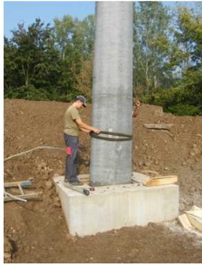
**Abb. 15 und 16: Aufrichten der Masten für die vertikale Schrotfangeinrichtung und Teil eines Fundaments**
