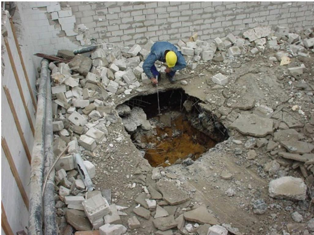
**Abb. 5:** Hohlraum unterhalb des Gebäudes Erlenring 7 im Jahr 2003, 25 Jahre nach dem (Pfehl-) Bau
