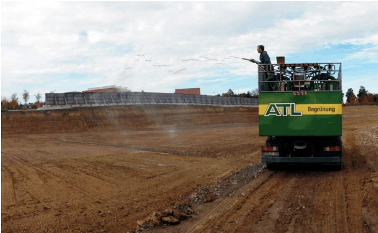
**Abb. 2:** Begrünungsarbeiten an der Baugrubensohle
