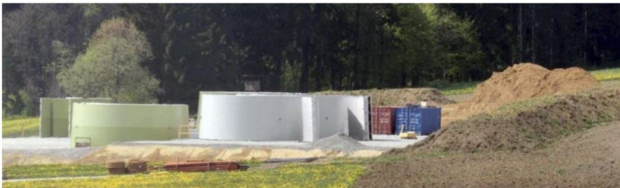
**Abb 2:** Übermassenverwertung in der Kranstellfläche, Humus- und Bodenlager an der Baufläche
