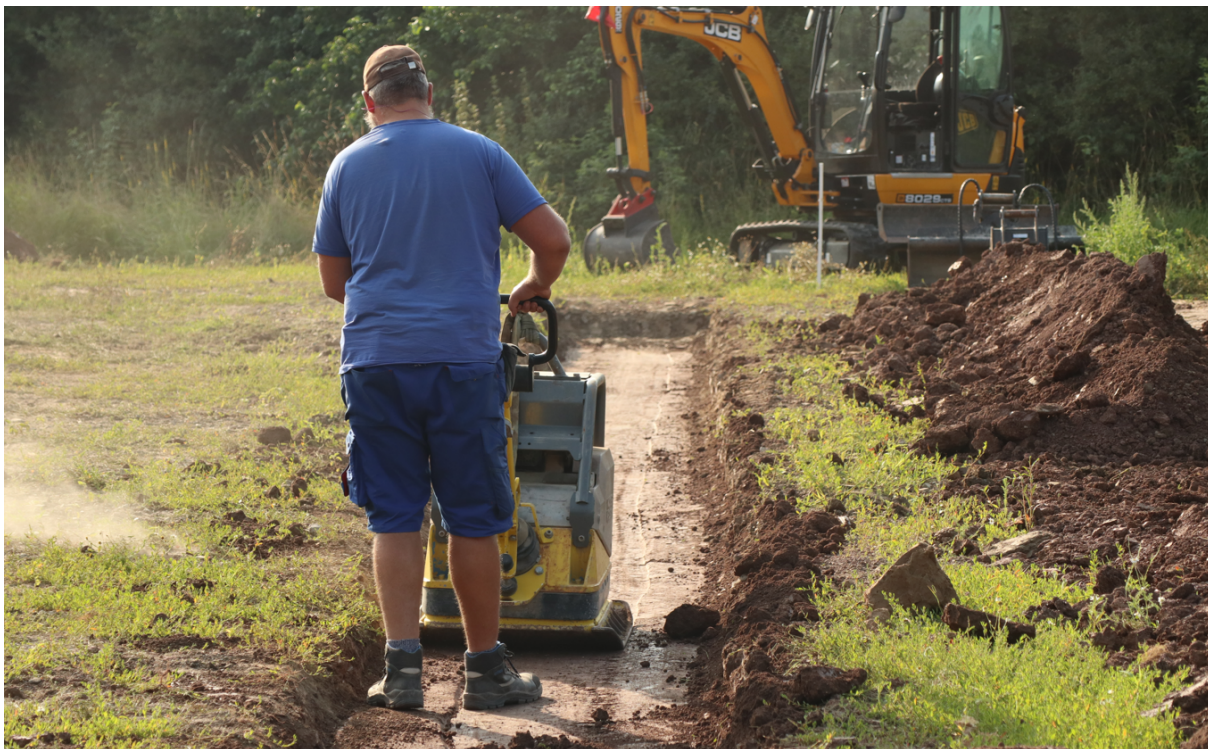
Abb. 5: Lagenweises Verdichten
