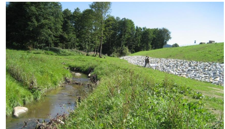
Naturnah ausgebauter Katzbach nach der Umverlegung; Böschungsfuß mit Erosionsschutz
