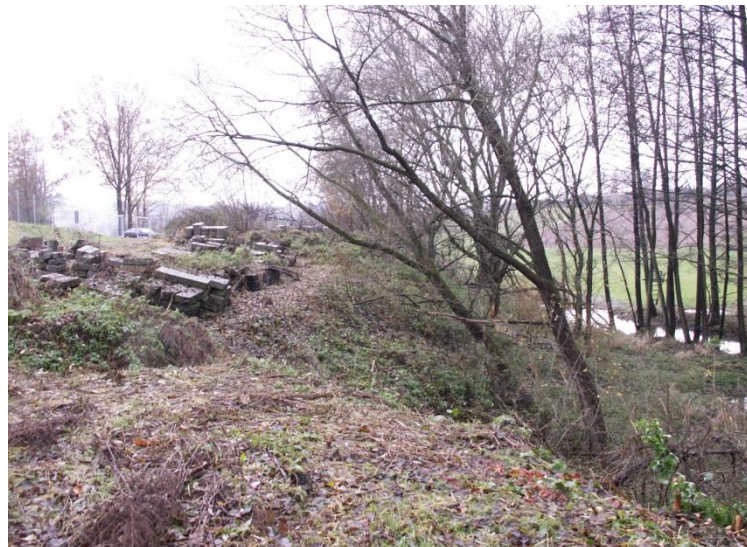
Deponie und behelfsmäßiges Baustofflager vor der Sanierung
