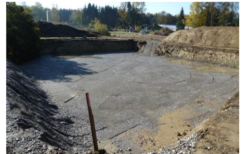
Sanierungsfläche nach Abtrag der kontaminierten Bodenschichten
