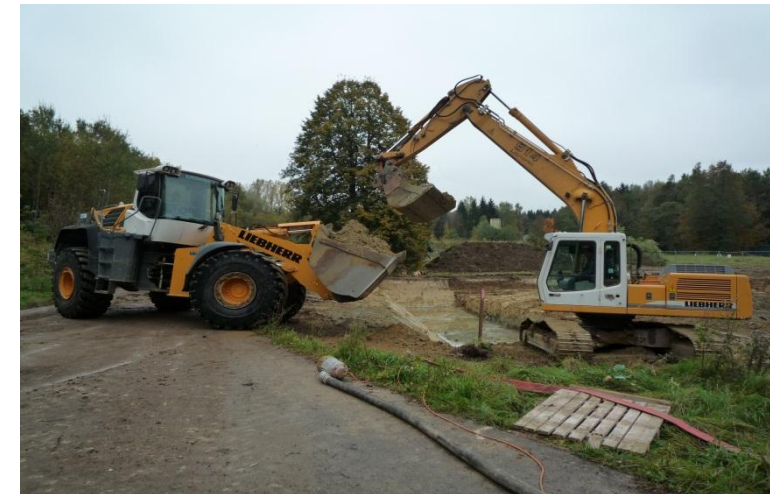
Abtrag des kontaminierten Bodenmaterials
