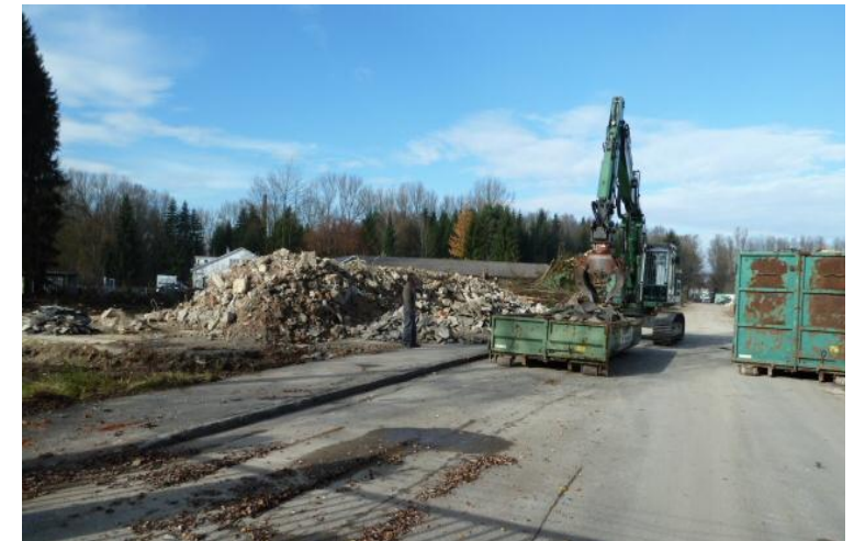
Abtrag von Bauschuttmaterial
