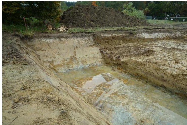
Streifenweiser Aushub
